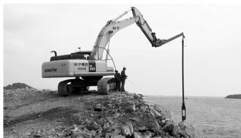
图4 液压履带式装药机
